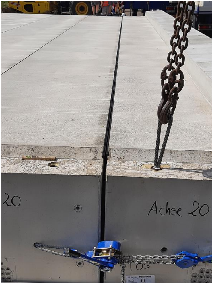
Bild 15: Schließen der Kontaktfuge zwischen zwei Überbau-FT mittels Kettenzug, dabei ist der Kran noch nicht lastfrei.
