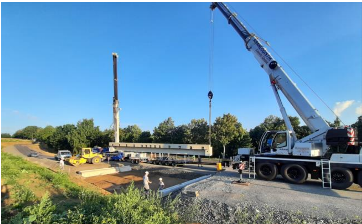
Bild 14: Montage der Überbau-FT mit 2 Kränen.
