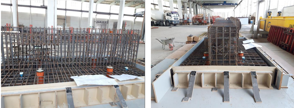
Bild 4: Bewehrungskorb eines Widerlagers mit Betonstahlbewehrung
