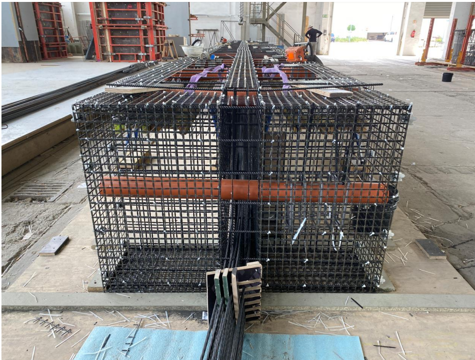
Bild 5: Teilweise hergestellter Bewehrungskorb des FT5 vor dem Einheben in die Schalung
