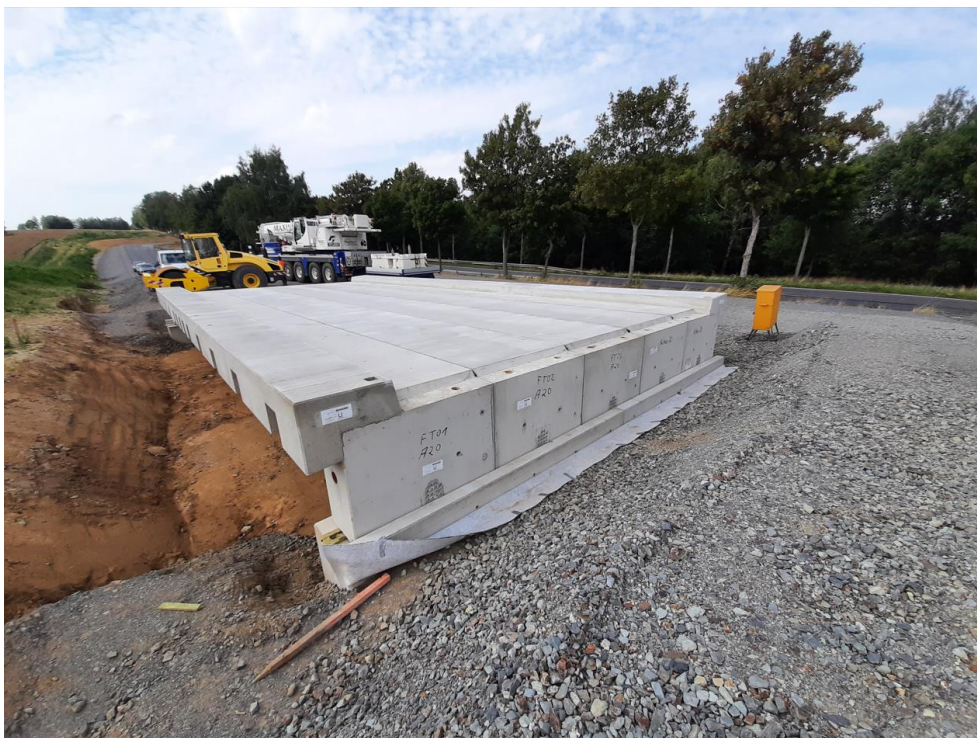
Bild 16: Ansicht nach Montage der Überbau FT, vor Quervorspannung.
