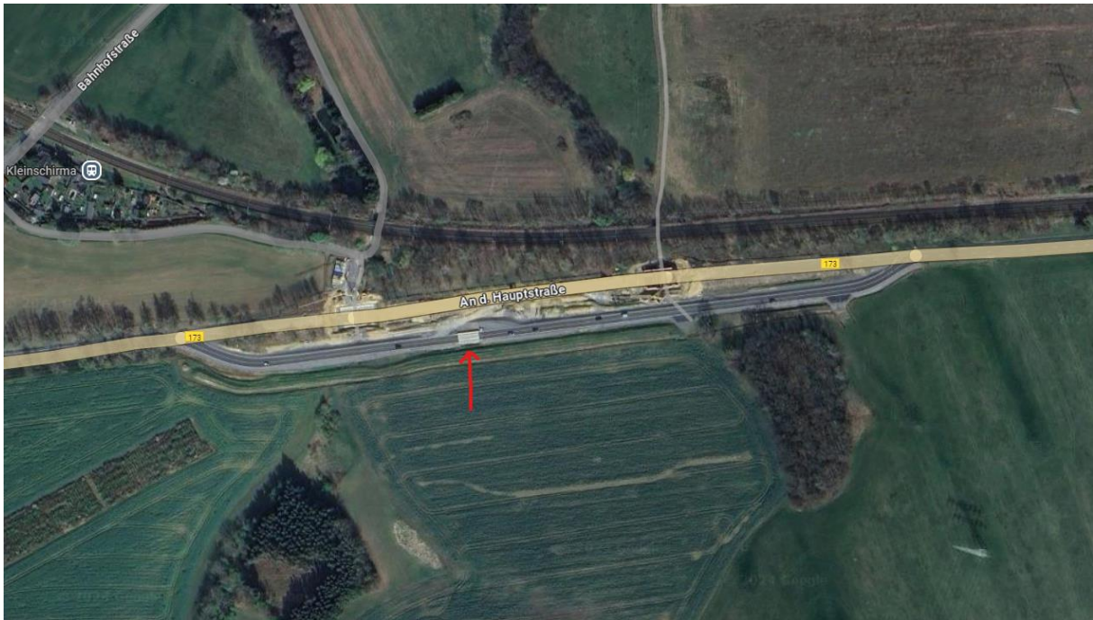
Bild 1: Luftbild des Pilotstandortes (Rotmarkierung) im Zuge einer bauzeitlichen Umfahrung an der B173 östlich von Freiberg/Sa. während der Betriebsphase des Pilotbauwerkes (Quelle: Google Maps)
