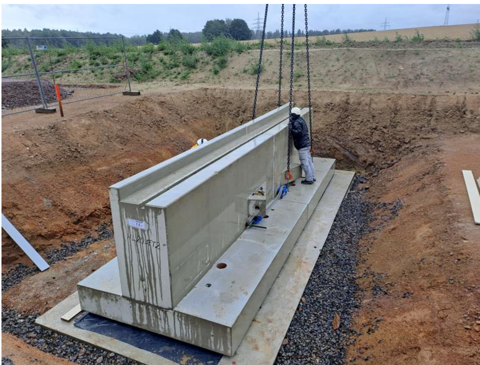
Bild 13: Montage der Widerlager-FT auf Planum/Sauberkeitsschicht.
