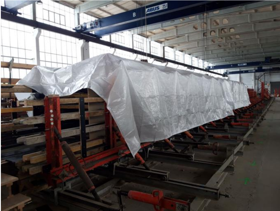
Bild 10: Nachbehandlung eines Überbaufertigteils
