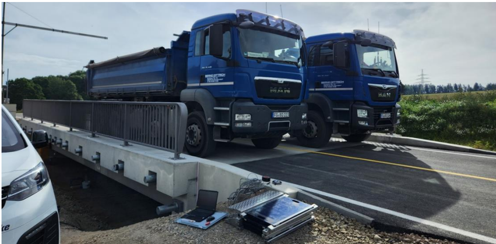
Bild 18: fertiggestelltes Pilotbauwerk während des Belastungsversuches vor Verkehrsfreigabe.
