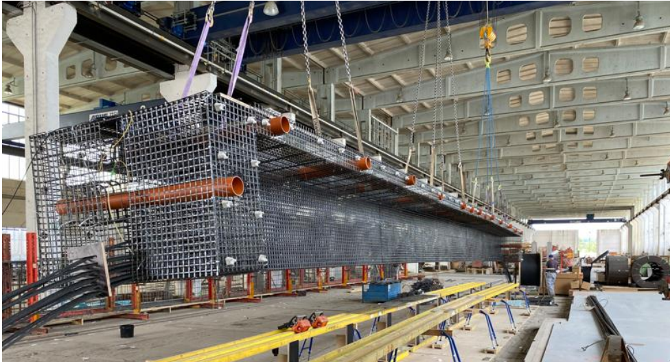
Bild 8: Bewehrungskorb beim Einheben in die Schalung
