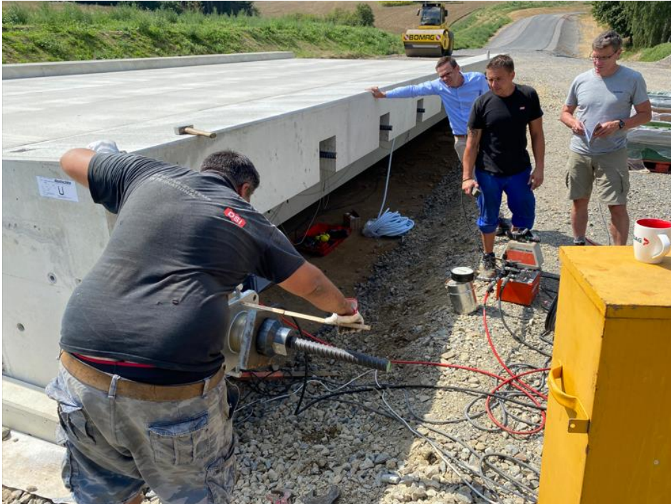
Bild 17: Vorspannen der Stabspannglieder der Quervorspannung unter Aufsicht des Prüfsingenieurs, hier Kontrolle des Pressenweges.
