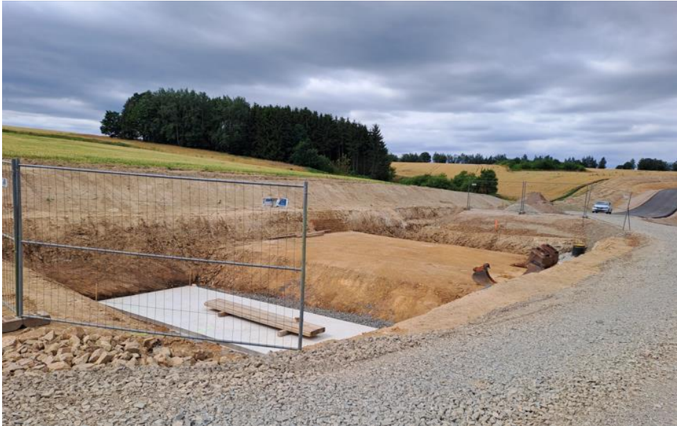
Bild 12: Situation auf dem Baufeld mit fertig gestelltem Planum vor Beginn der Montagearbeiten.
