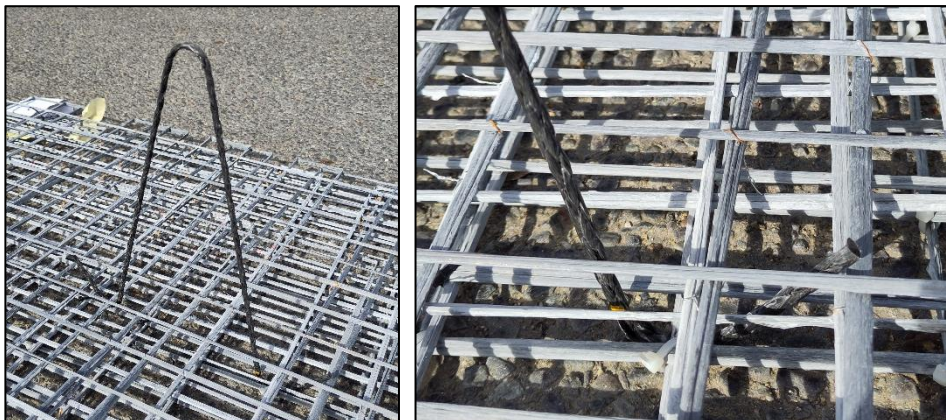
Abbildung 6: Nichtmetallischer Transportanker zur Aufhängung der Bewehrung für den innerbetrieblichen Transport
