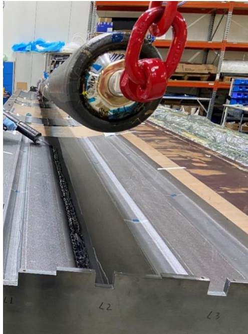
Abbildung 22: Verklebung des Tankröhre H-2 mit der UFS
