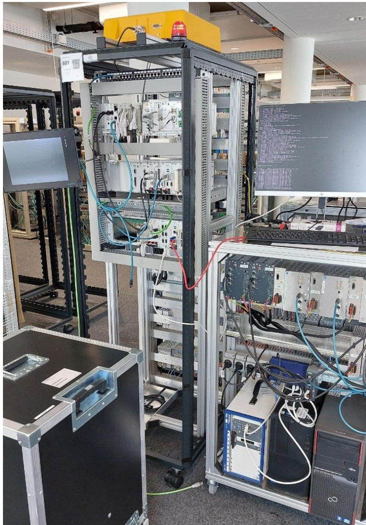
Abbildung 49 Aufgebauter GoA2 Teststand
