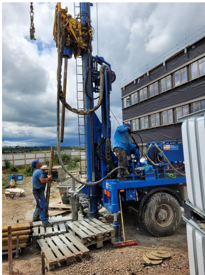
Abbildung 11: Bohranlage der Fa. Handke Brunnenbau, eingesetzt auf den beiden Geothermiebohrungen in Mainz-Bretzenheim.
