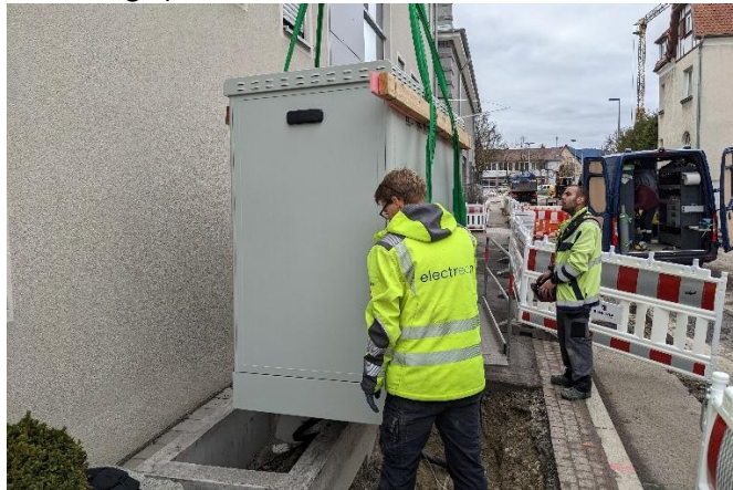
Abbildung 2: Aufstellen der Management-Unit per Kran
