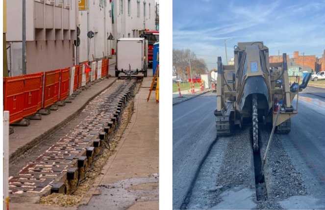
Abbildung 1: Kabelgraben in Balingen mit Bagger erstellt (links), in Detroit mit Grabenfräse erstellt (rechts)
