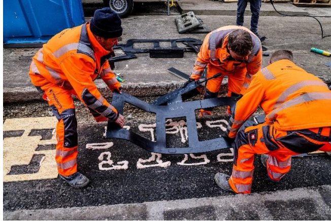
Abbildung 3: Verlegen & Verkleben der Spulen auf Asphalttragschicht
