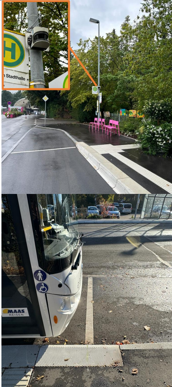
Abbildung 26: Bushaltestelle Charlottenstraße: Lidarsensor und Haltelinie
