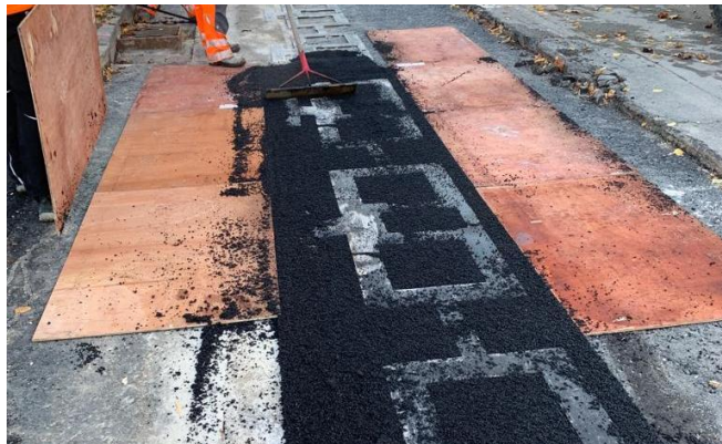
Abbildung 4: Aufbringen von feinkörnigem Asphalt zur anschließenden gleichmäßigen Verdichtung v. Binder- und Deckschicht
