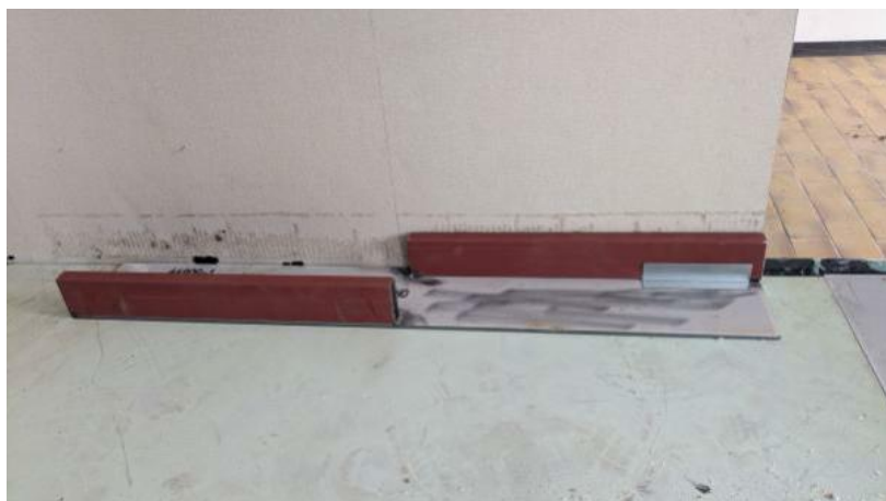
Abbildung 6: Einsatzbeispiel geklebte Winkel zur Lagesicherung von Kabinen (Quelle: MEYER WERFT)
