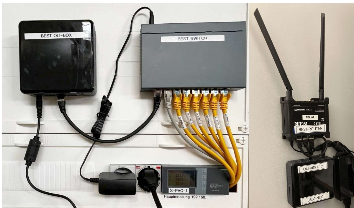
Abbildung 5: Intel NUC Einheit "BEST OLI-BOX", Siemens Messgerät PAC 2200 und Switch für insgesamt sieben Messgeräte an einem teilnehmenden Industriestandort, Teltonika Router für die Kommunikation zum Strommarkt
