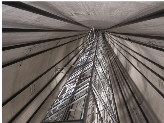
Abbildung 18: Innenansicht des Spannbetonteils eines Hybridturmes.
