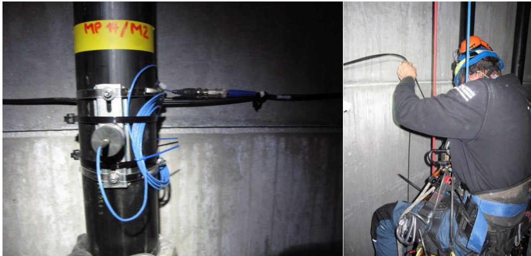
Abbildung 5: Messstelle zur Erfassung der Seilbeschleunigungen installiert mit Hilfe von Industriekletterern.
