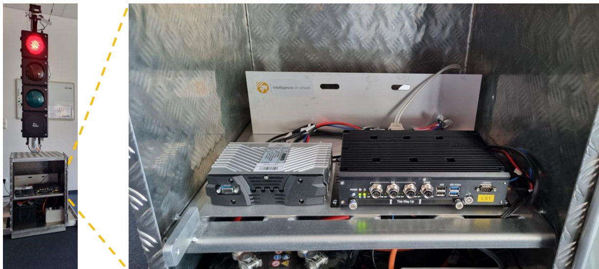
Abbildung 14: Steuereinheit und LSA-Schnittstelle
