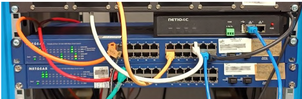
Abbildung 10: Zwei Netzwerk Switches (blaue Komponenten) für das MGMT und das LDAN Netzwerk.
