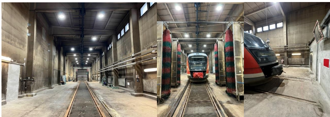
Abbildung 3: Ausgerüstete Waschhalle mit dem Versuchsfahrzeug
