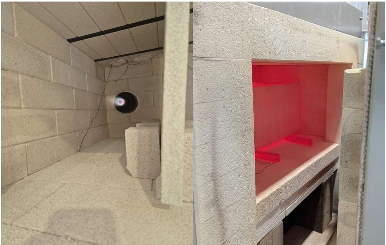
Abbildung 3, Links: Blick auf den Brenner mit Spaltgasflamme; Rechts: Blick in den Ofen im Betrieb mit rotglühenden Ziegeln
