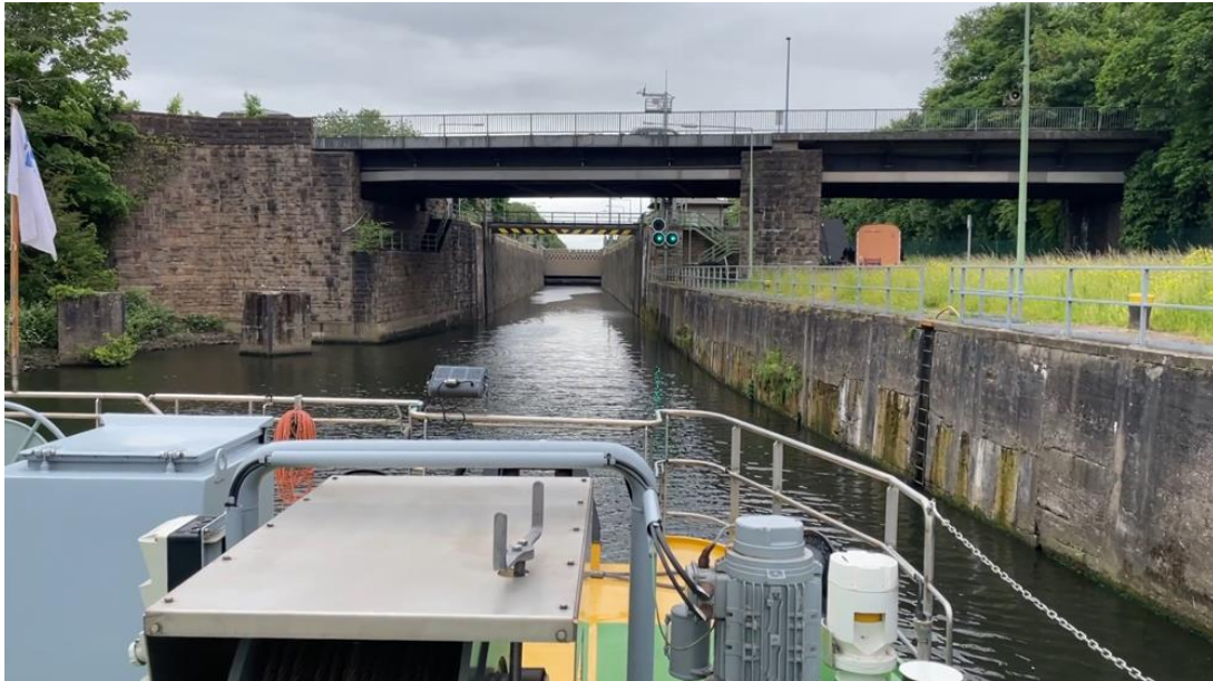
Abbildung 19: Einfahrt in die Schleuse Raffelberg bei Duisburg
