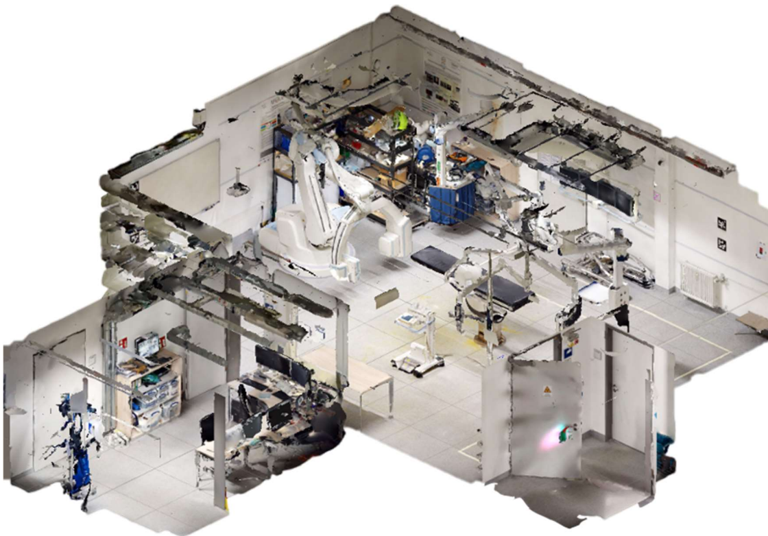
Abb. 1: 3D-Scan des experimentellen, hybriden OP-Saals inklusive der installierten Geräte und Infrastruktur
