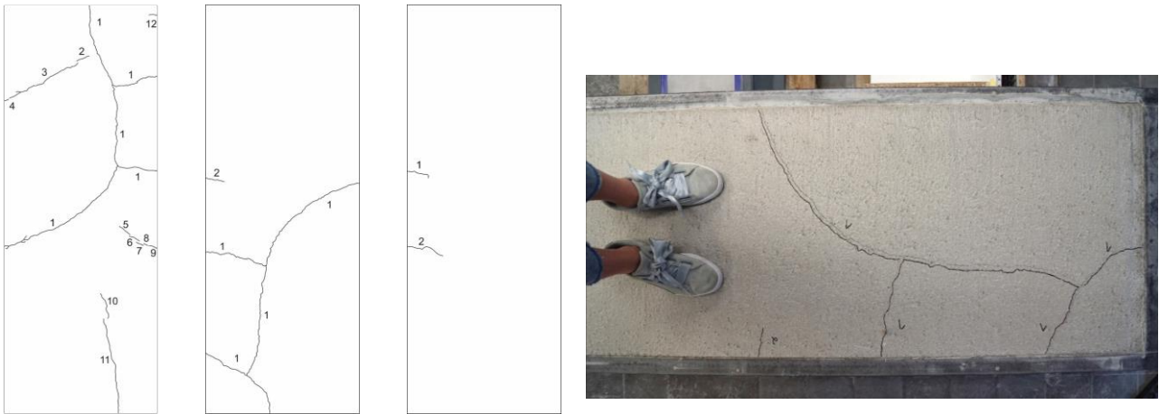
Bild 49: Ergebnisse Windkanal - Risskartierung
