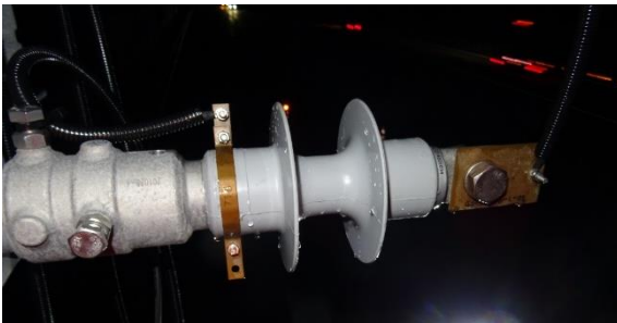
Abbildung 23 - Anschluss der Referenzisolatoren an die Fahrleitungsspannung und Schelle zum Abgriff des Ableitstromes
