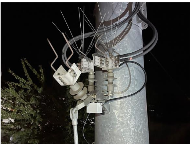
Abbildung 14 - Installierte Abschlusselemente im FeSH-Testfeld
