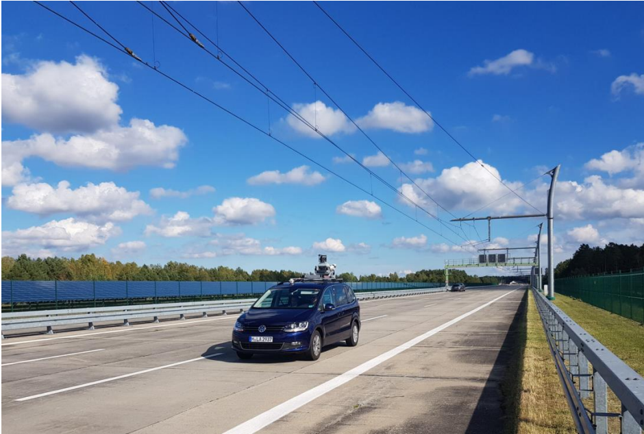
Abbildung 4 - DTC Befahrung auf der Versuchsanlage Groß Dölln
