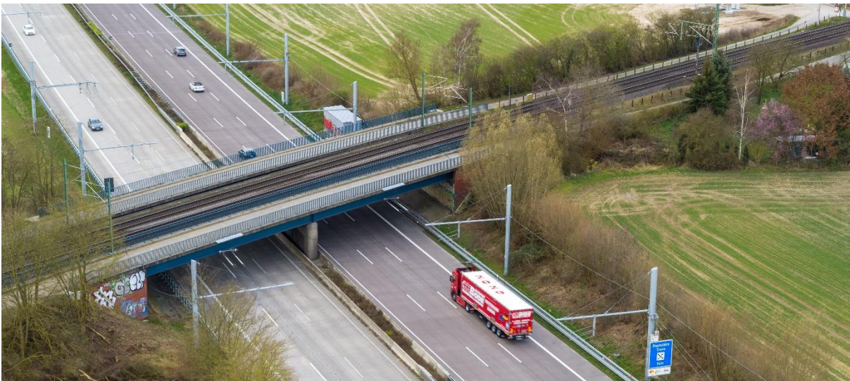
Abbildung 17 - Ansicht der Eisenbahnbrücke mit Deckenstromschiene
