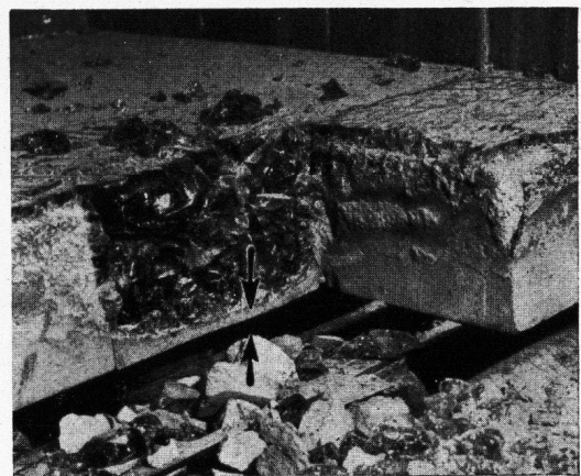
Bild 1. Einzelner völlig zerstörter Bodenstein im Verband mit anderen unbeschädigten Steinen.
