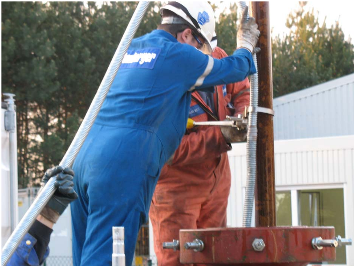
Abb. 2.9: Einbau der Schlumberger elektrischen Tauchpumpe (ESP)
