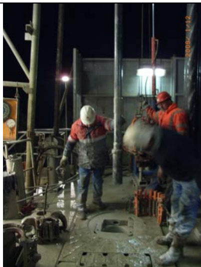
Abb. 3.5: Ausbau des gefangenen „Fisches“ (oberer Teil) des Packers
